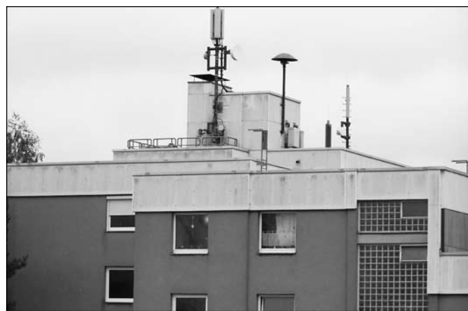
Abb. 1: Mobilfunksendeanlagen auf dem Hochhaus in der Feldstraße 28, Selbitz, Oberfranken.
